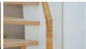
藤皮を、住宅の階段の手すりに。藤は、古くから刀の柄などに巻かれていたように、滑り止めとしても機能します。
